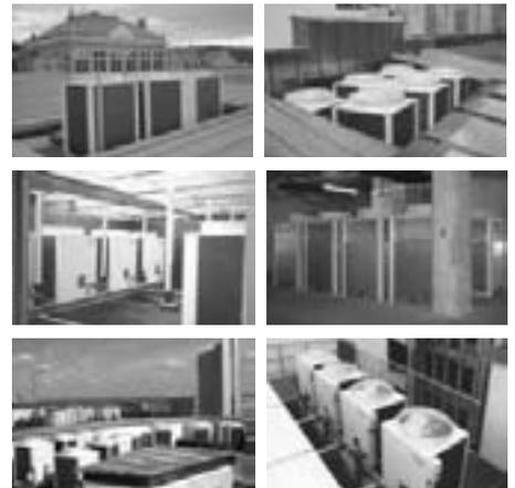
Bilder 2: Innen- und Außenaufstellung von VRF-Außeneinheiten
