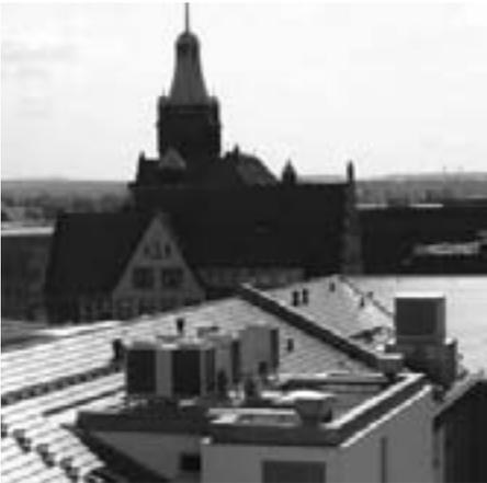
**Bild 3 b: Platzsparende Dachaufstellung von VRF-Außeneinheiten**
