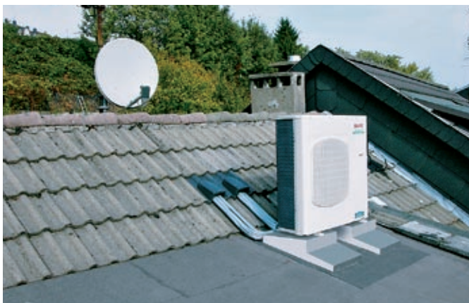
Direkt auf dem Dach aufgestellt, gibt es kurze Leitungswege, außerdem stört das Außengerät hier niemanden.
