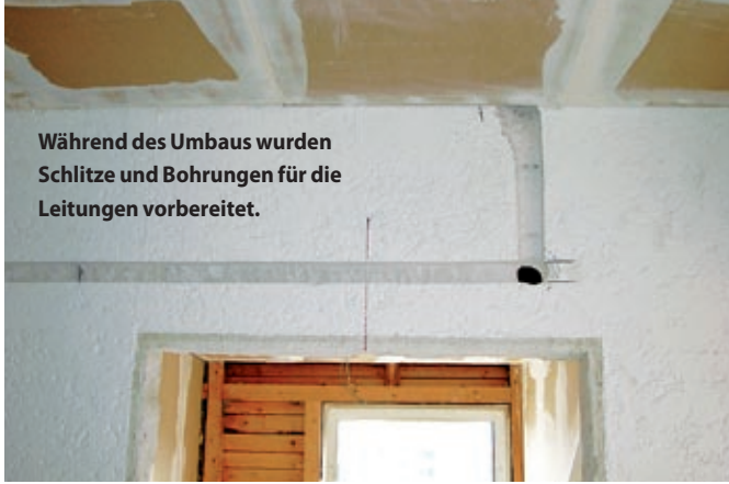
Alles wird vorbereitet, ehe das Innengerät installiert werden kann.
