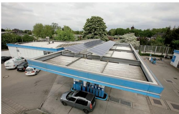
Dachinstallation der Kaut-Wärmepumpe und Fotovoltaik-Module auf der ARAL-Tankstelle
