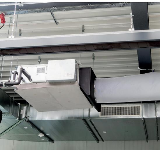
*Kanalgerät mit max. 4300 m<sup>3</sup>/h für Umluft- oder 100% Frischluftbetrieb*
