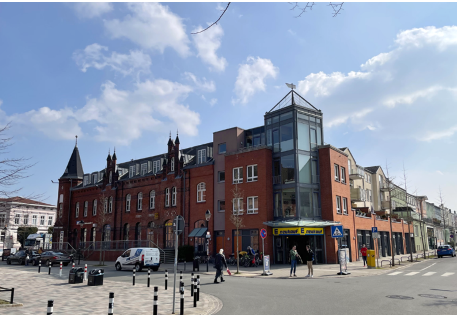
Modernisierter EDEKA Markt in Warnemünde ausgestattet mit VRF-Klimasystemen von Panasonic
