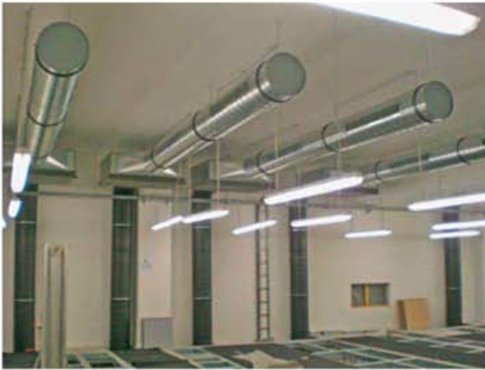
Erster Installations- abschnitt der Server- raumklimatisierung.
