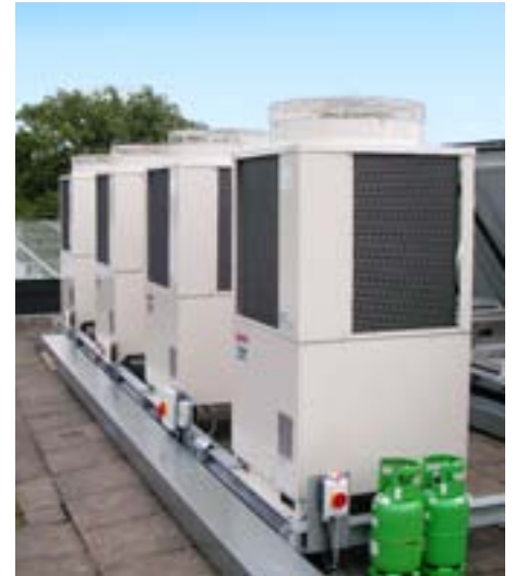
Die vier Außeneinheiten sind auf dem Dach platziert.
