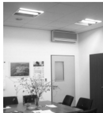
Eigentlich hätten sich für die Inneneinheiten Kasettengeräte angeboten, aber der Architekt bestand in diesem Fall auf Wandgeräte.
