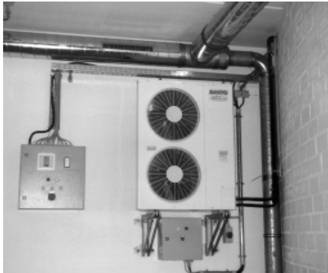
Bild links: Die drei Außeneinheiten SPW C 703GYH8 für die Klimatisierung der 4. Etage.
