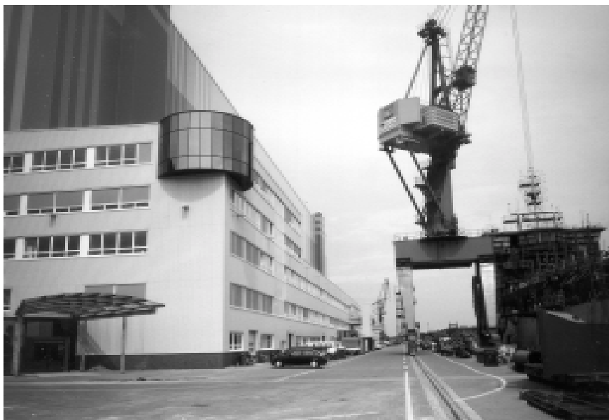
Im Bürogebäude der Volkswerft Stralsund wurde nachträglich die 4. Etage sowie das Foyer im Erdgeschoß mit einer ECO-Multi-Splitanlage klimatisiert.
