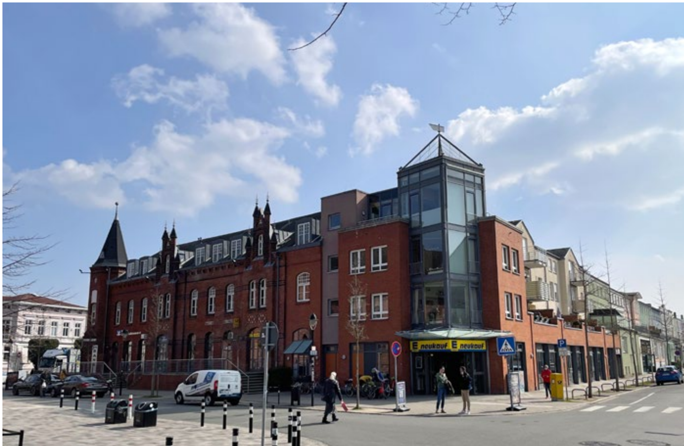
Modernisierter EDEKA Markt in Warnemünde ausgestattet mit VRF-Klimasystemen von Panasonic
