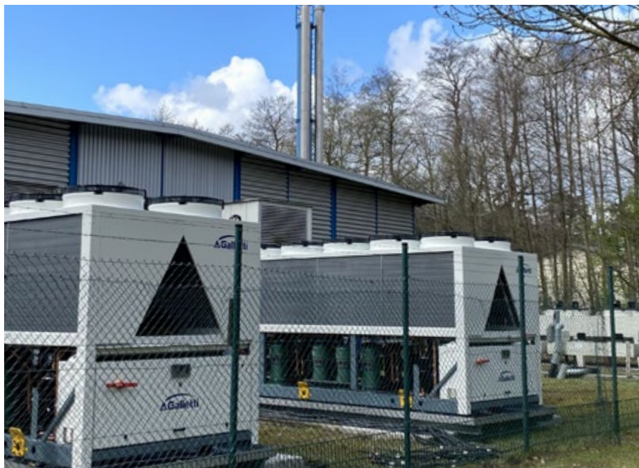
GALLETTI-Sonderlösung: Freikühlmaschinen mit integrierter hydraulischer Systemtrennung
