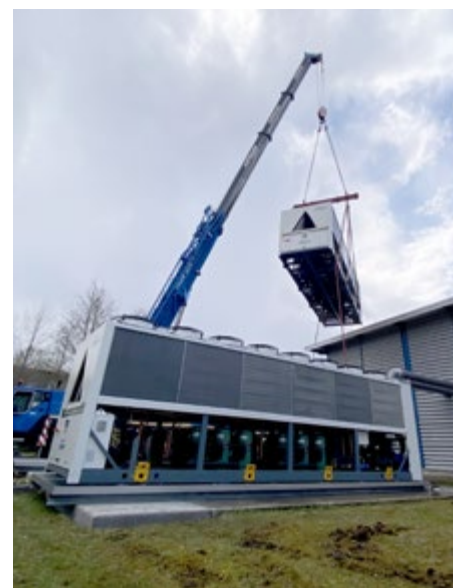
GALLETTI-Sonderlösung: Freikühlmaschinen mit integrierter hydraulischer Systemtrennung
