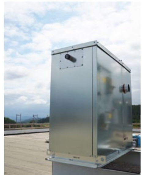
driSteem Gasdampfbefeuchter zur Dampferzeugung auf dem Gebäudedach
