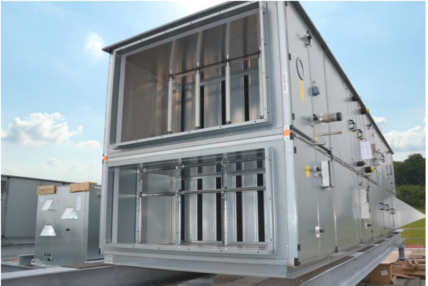
Bereits im Werk in die RLT-Anlage integrierte Rapid-Sorb Dampfverteiler von Kaut
