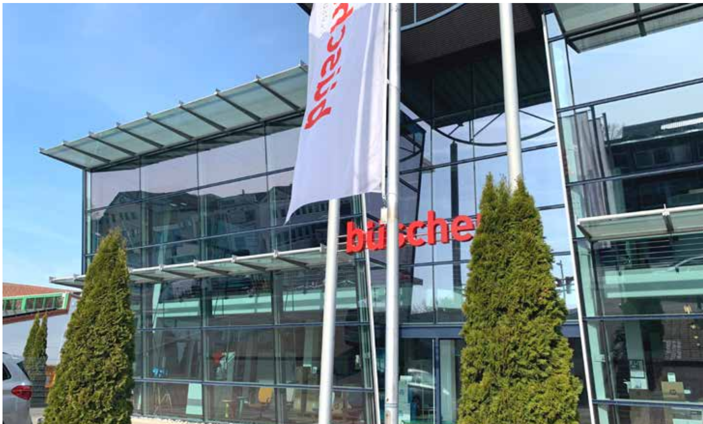
Im Industrielook gestaltete Ausstellungsräume der Büscher GmbH klimatisiert
