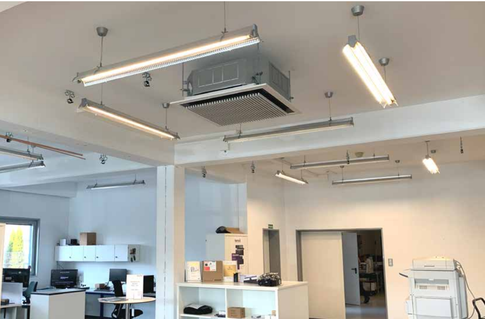
Montage des Kassettengeräts mit mehrfach prämierter Design-Blende von Hitachi (S. 10)
