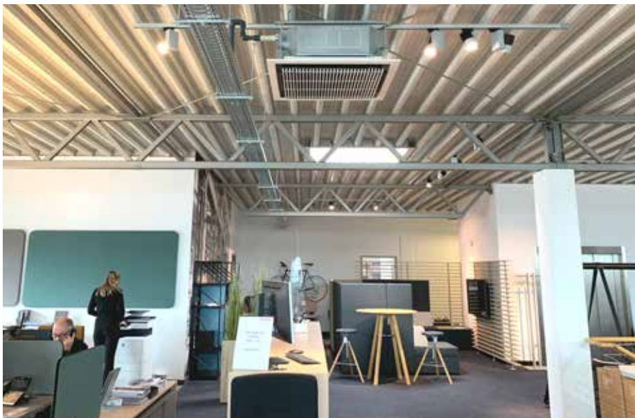
Harmonische Integration der Kassettengeräte in die umgebende Decke durch offene Montage
